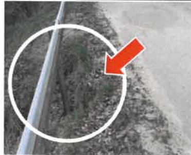
Zapadlisko i wymyście skarpy ul. Gdańska na wysokości nr 59
