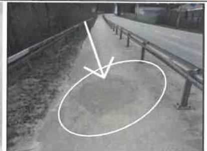
Zapadlisko i wymyście skarpy ul. Gdańska na wysokości nr 59
