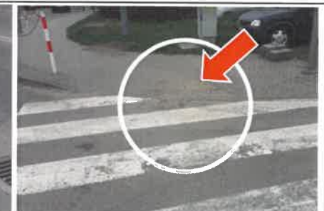
Ul. Wojska Polskiego: zapadnięty chodnik na wys. budynku nr 45, ubytki chodnika przy przejściu dla pieszych wjazd MPEC/tartak
