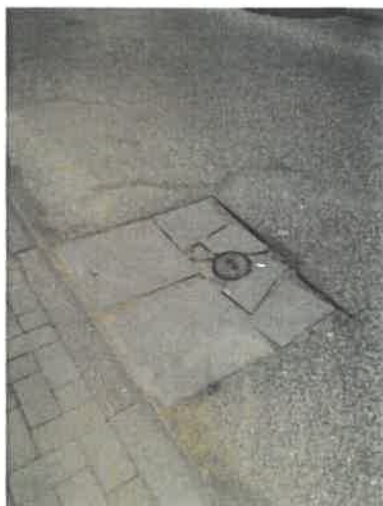
Uszkodzona studzienka na dalszym odcinku w stronę DPS, oraz kolejna po stronie budynku 43
